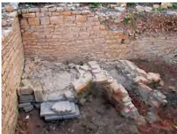
Fig. 4 Le fornaci nel vano 36
